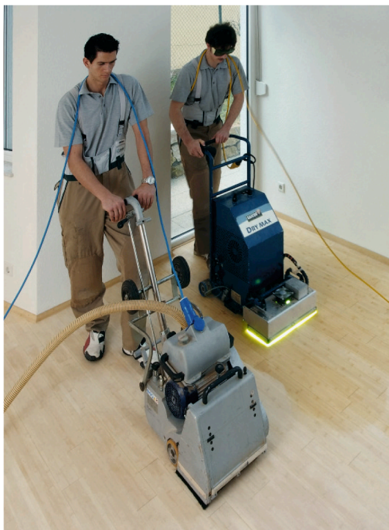
Sein Angebot umfasst das staubfreie Schleifen von Parkettböden. Durch den Einsatz von UV-Technik sind die behandelten Böden augenblicklich begehbar
