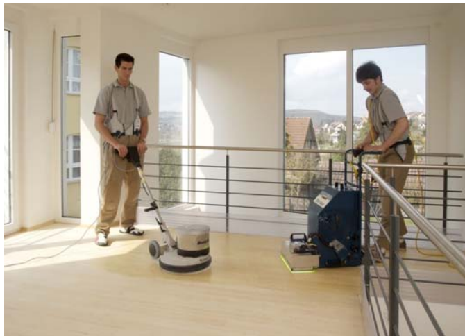
Moderne Technik macht es möglich, in einem Raum das Parkett zu schleifen und gleichzeitig zu versiegeln. Foto: PR
