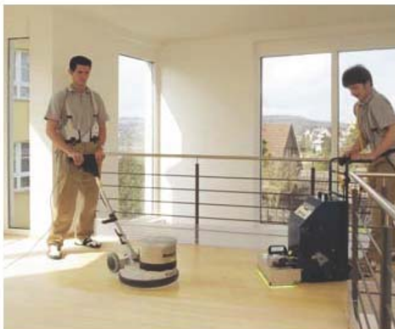
Das Fußbodenöl wird mit einem mobilen UV-Licht-Gerät gehärtet und kann direkt anschließend gebohrt werden
