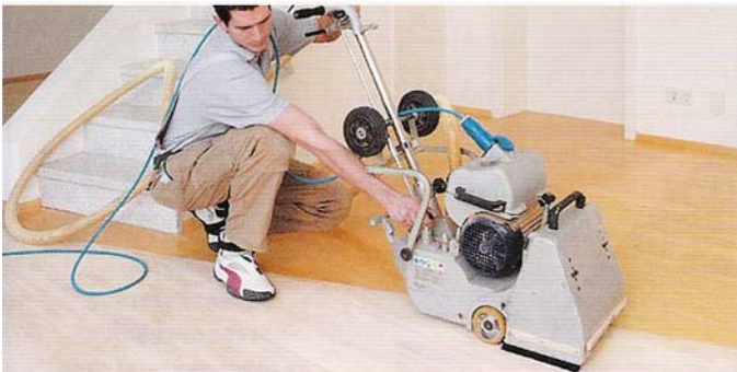
Staubfreies Schleifen: Ein bis zu 300m langer Schlauch verbindet das Schleifgerät mit der Absaugenheit. Die Anlage verhindert so das Entstehen von kleinsten Mengen von Feinstaub.
