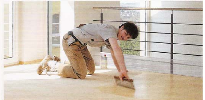
Einölen: Nachdem der Boden geschliffen wurde wird mit einem Spachtel ein spezielles Öl gleichmäßig auf dem Boden aufgetragen.
