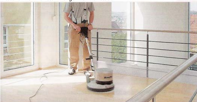
Das aufgetragene Öl wird mit einer Poliermaschine gleichmäßig fein auf dem Boden verteilt und die Oberfläche beginnt matt zu glänzen.
