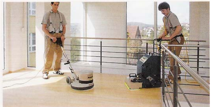
UV-Versiegeln: Für das Oberflächenfinish verwenden die Holzwurm-Profis einen Zwei-Komponenten-Lack, der durch das Bestrahlen mit UV-Licht augenblicklich aushärtet und sofort begehbar ist.
