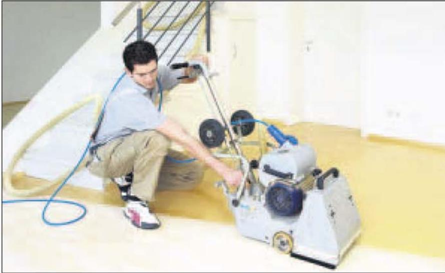
Ein Mitarbeiter der Firma „Holzwurm“ schleift Parkettboden. Per Schlauch ist die Maschine mit einer Absaugstation verbunden.
