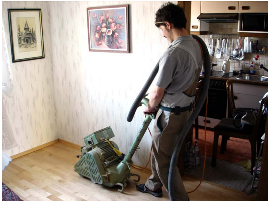
Holzwurm Mitarbeiter mit seinem Staub absaugenden Parkettschleifer
